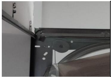
*Usile cu sistem LHR pot fi dotate doar cu chedere de grinda ( in varianta cu cheder de profil acesta risca sa frece plafonul garajului )*
