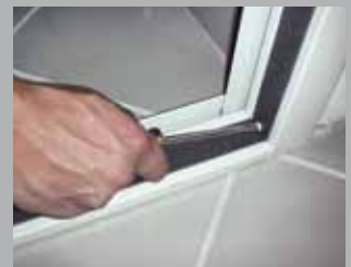
Remove the distancer for installation help Rimuovere il distanziale di aiuto posa
