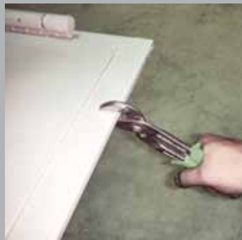
Reduce the lower frame to distancer for installation help Ridurre il telaio inferiore a distanziale di aiuto posa
